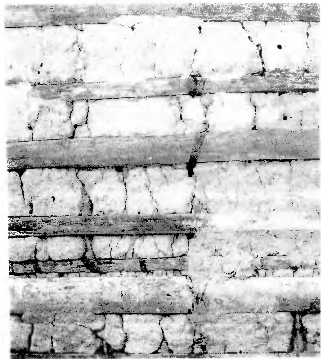
Detalhes de tradicional casa caiçara – detalhes do telhado e de uma parede – Barro, madeira local e amarrações com cipó.
